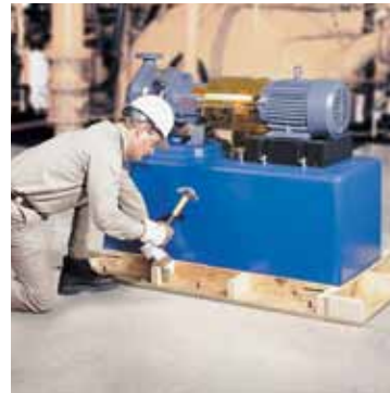
Install bottom edge forms.
